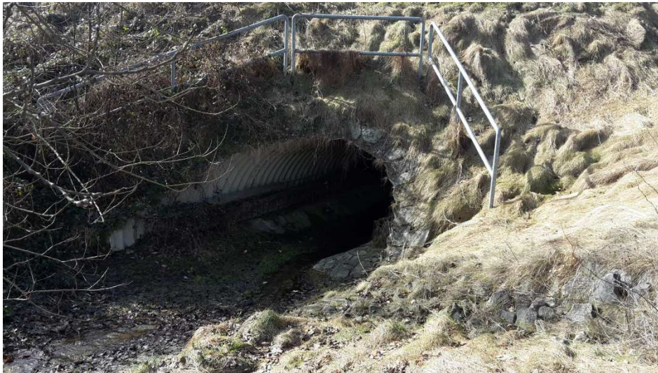
Abbildung 3: Einleitungsstelle AI, Unterführung unter St 2148
