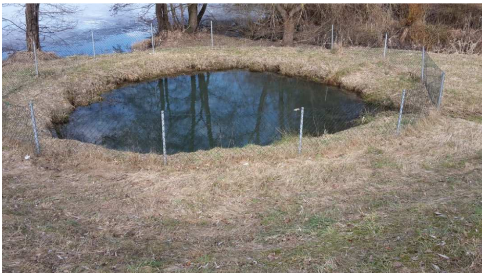
Abbildung 3: Bestehendes Regenklärbecken mit Dauerstau vor der Einleitungsstelle
